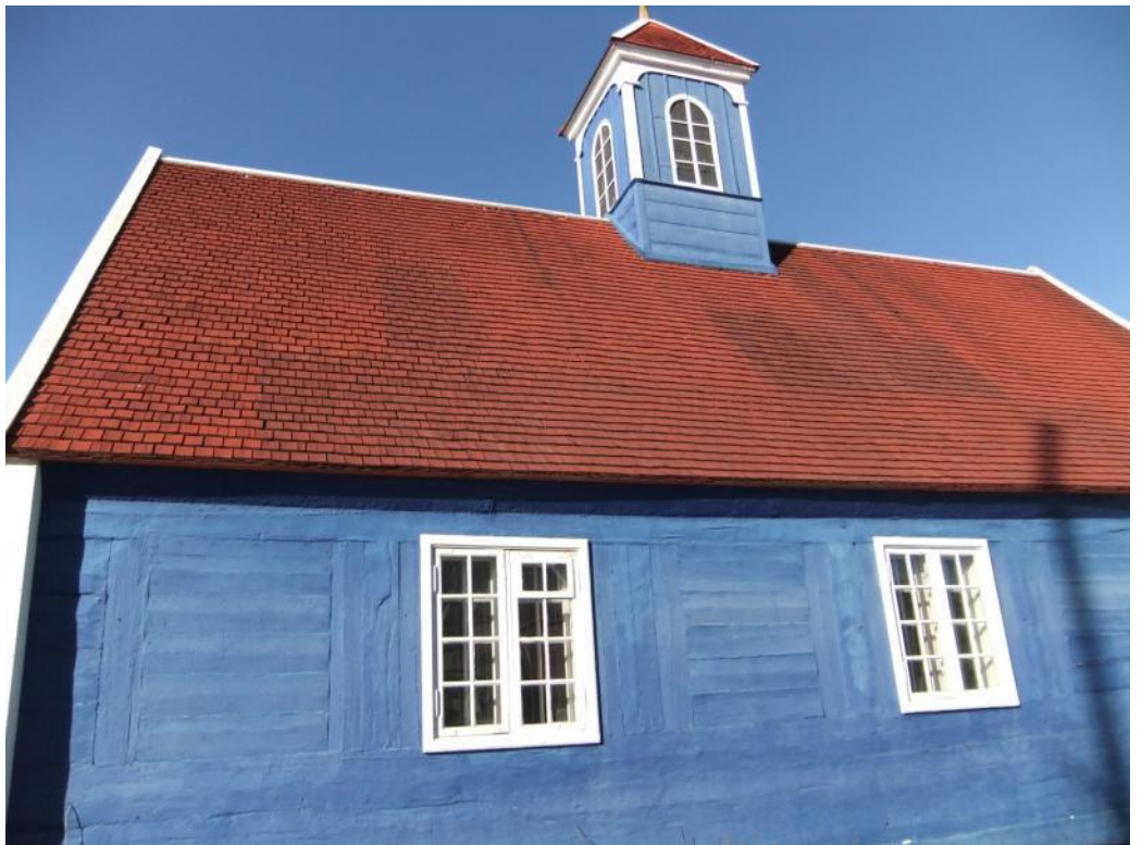
Andre hvert er fjernet ellers er den kraftige planken på hver side av vinduene samme detaljen som på den "Blå kirke" og de øvrige tømrede bygningene.
