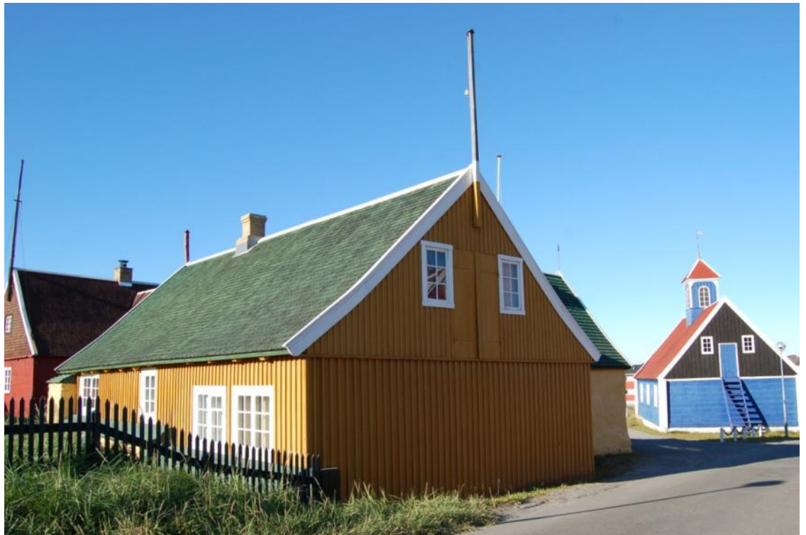
Gavl mot nord og vegg mot øst
