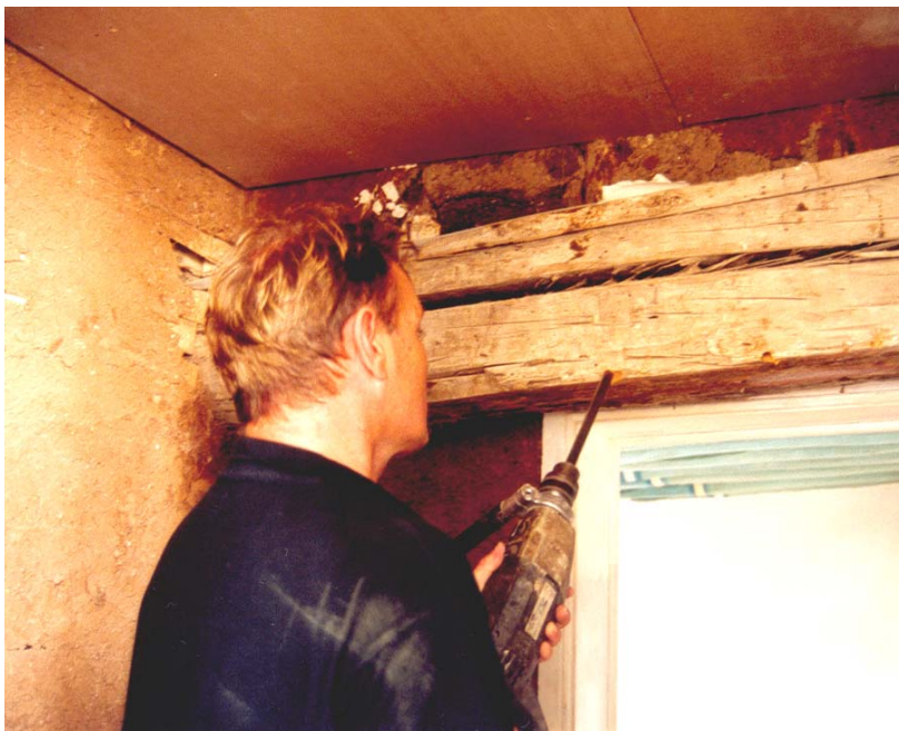
Abbildung 8 Probe 24, Probennahme mit Bohrgerät. Pappelbalken in der Wand des kleinen Raumes neben der neuen Küche der Direktorenwohnung, tragender Balken, ca. 25x25cm. Wahrscheinlich handelt es sich um einen wiederverwendeten Balken, der evtl. vom Iwan stammt.
