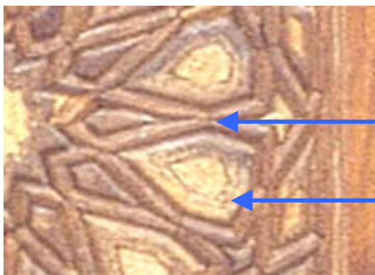
Abbildung 13 Detail einer 'Puzzle-Tür'. Verbindungsstege aus Zypressenholz Sechsecke (der etwas dunklere Teil davon) aus Walnussholz
