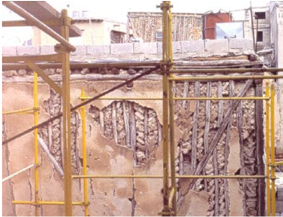
Abbildung 3: Ein etwas ältere Ausgabe einer Lehmziegelwand. Pfosten und Balken aus Pappelholz.
