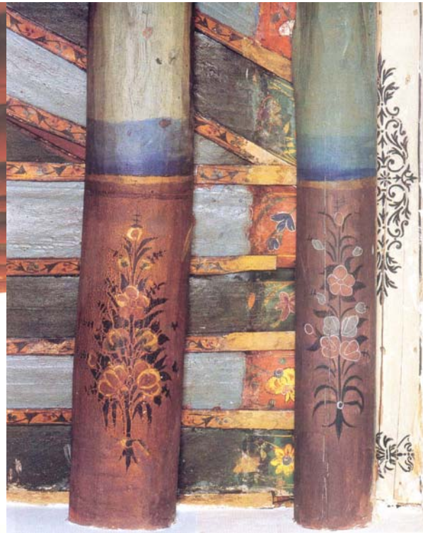
Abbildung 10 Die reich verzierte Decke des Vorzimmers des Instituts. Balken, Deckenpaneele und -leisten bestehen aus Pappelholz.
