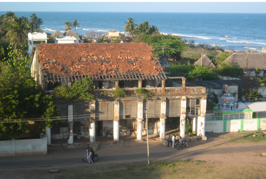
Den tidligere danske guvernørbolig – en bygning i tiltagende forfald.
