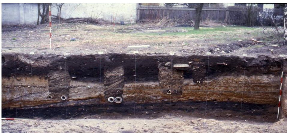
Fig. 12. Stationsvej 17-19. Udgravninger i byområdet i Vedbæk giver interessante indblik i byens kloakeringsforhold m.m.
