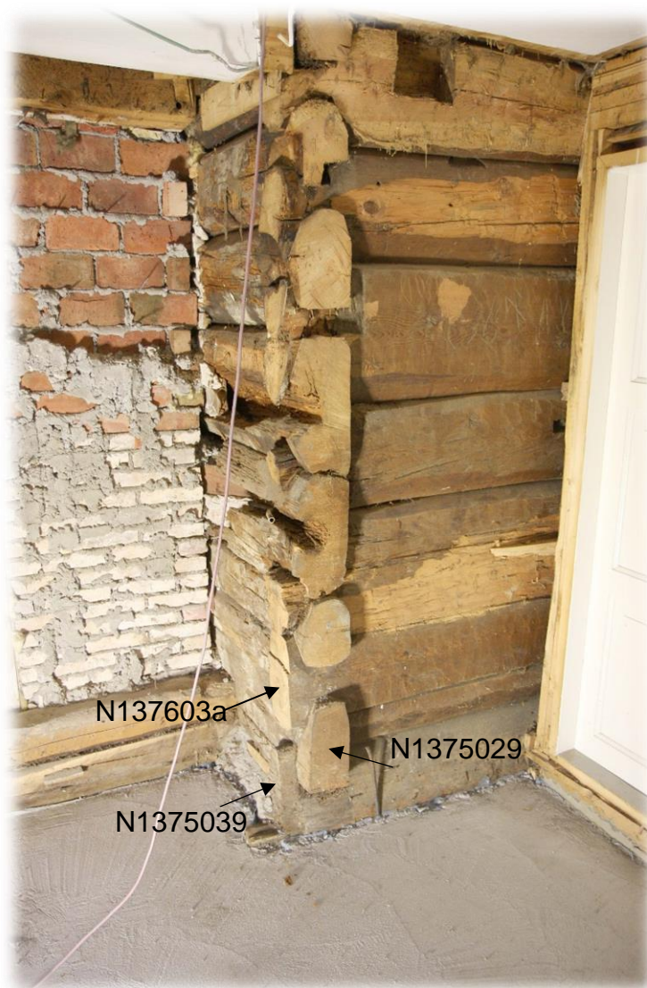
Figur 2: Hjørne af den gamle tømmerkerne frilagt.
