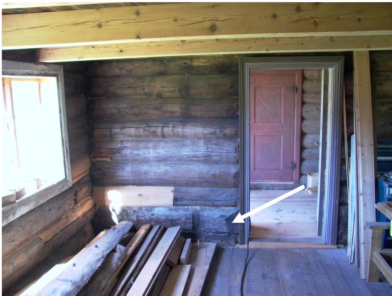
Svill N0860t03 i væg mellem gang og midtstue. Foto 2007.
