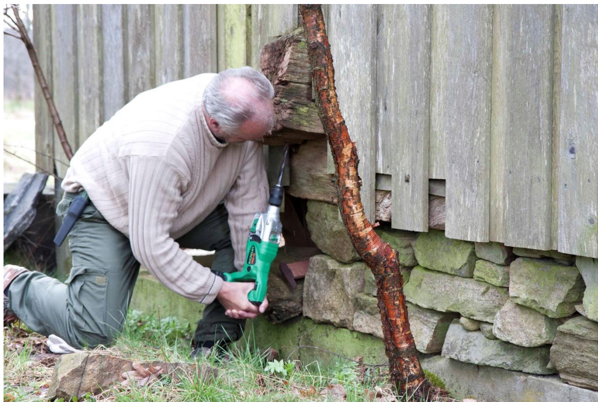
Udtagning af borekerne fra svill N0860019. Foto 2008.
