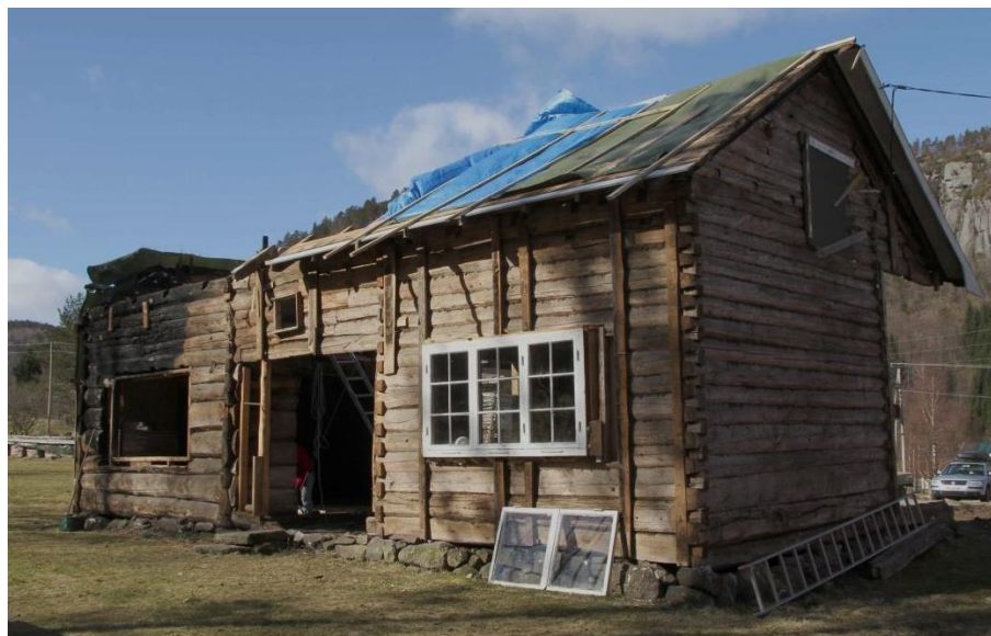
Trækonstruktion i Våningshus. Foto: VAF.
