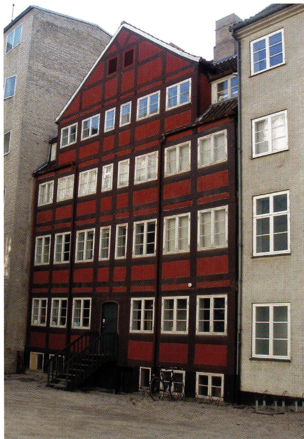
Åbenrå 26 set fra bagsiden. Huset er et typisk eksempel på byggestilen efter 1737, hvor en kgl. resolution „forviste“ bindingsværk fra gaden til gården, hvilket fik betydning for de mange huse, som blev opført efter Københavns brand i 1728.
