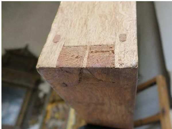
Rammeværkets planker er samlet med tappe og dyvler
