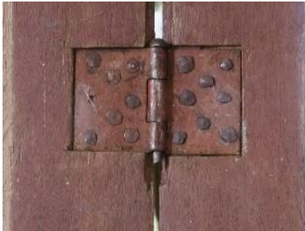
Hængsel påsat med håndsmedede søm. Igennem hængslets øskner er isat en stabel
