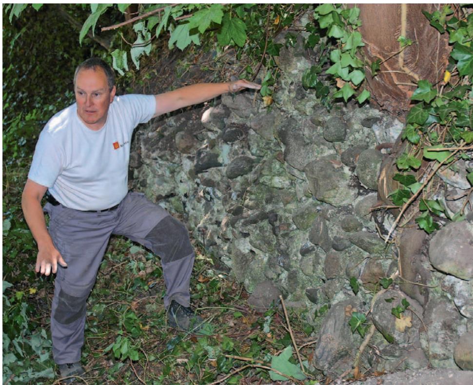
Fig. 5. Arkitekt Jørgen Frandsen fra Kulturarvsstyrelsen undersøger den synlige forsvarsmur mod øst. Den er hovedsagelig opbygget af kampesten sat i en solid kalkmørtel. Foto: Hans Skov 2008.
