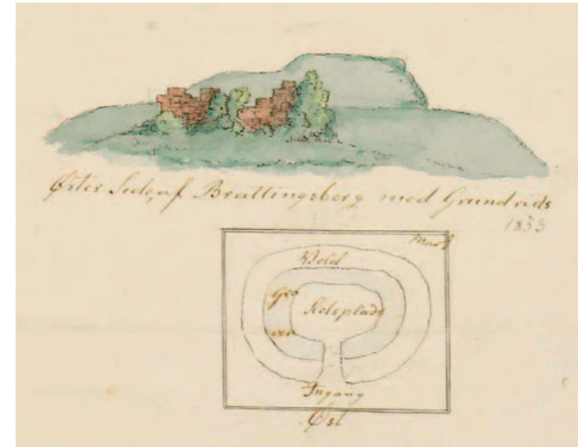
Fig. 13. »Østre side af Brattingsborg med Grundrids«. Detalje fra L. Schiøtz' Samsøkort (fig. 1) fra 1853. På den tid har indgangen fra øst og den indre voldgrav stadig været tydelig. Man får også antydning, at der var væsentlig mere bevaret af den østre forsvarsmur, end vi ser i dag. Tegning i Antikvarisk-Topografisk Arkiv, Nationalmuseet.
