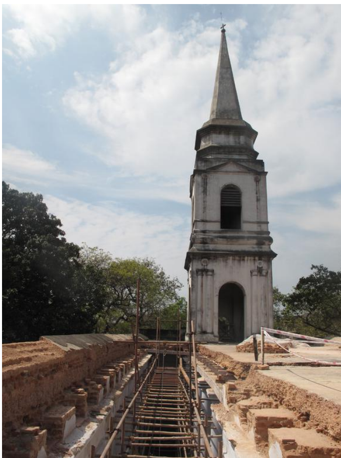
Skt. Olavs Kirke under restaurering. Foto: Bente Wolff, 2014
