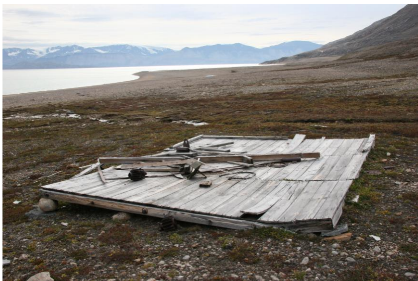
Fig. 58. Anlæg C. Resterne af trægulv
