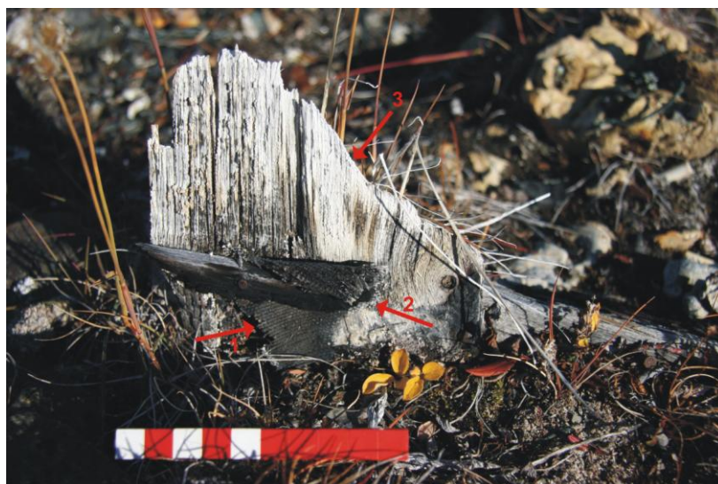
Fig. 70. Fragment af væg på Alte Hütte, rester af sejldugsbeklædning (1) ses under kantlisten (2), der er fastgjort på vægbrædderne (3).
