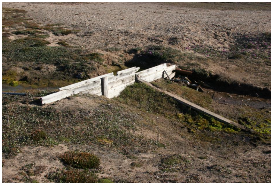
Fig. 36. Anlæg M, dæmning set fra sydsydøst
