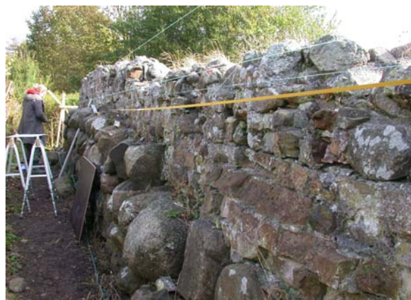
Fig.1. Opmålingen af stenhusets nordmur er i fuld gang. Der er stadig bevaret en del teglsten i murværket.
