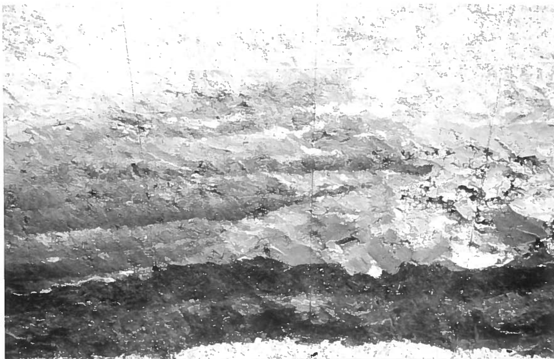
Fig. 8. Grøft 2, 1994, sydlige profilvæg. Dæmningens østlige græstørvopbyggede front. De enkelte tørv ses tydeligt. Jf. profilopmåling, bilag 2.
