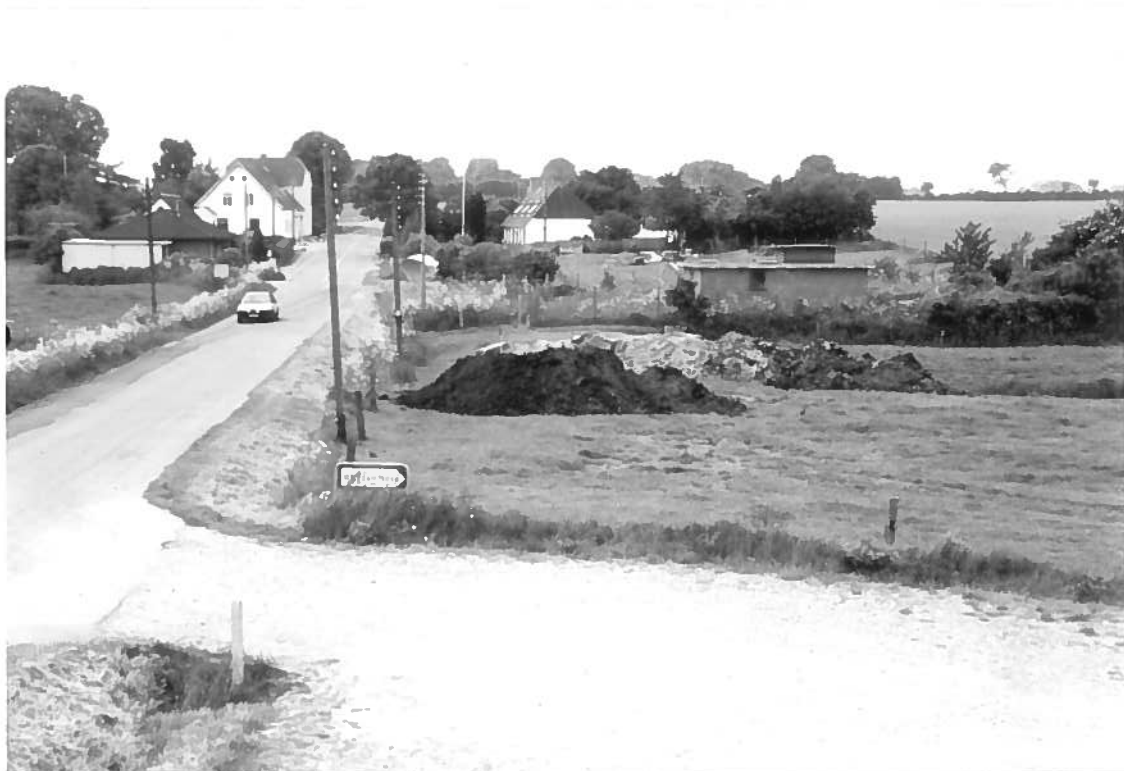
Fig. 5. Undersøgelsesområdet vest for Skolevej i 1994, set fra nord.
